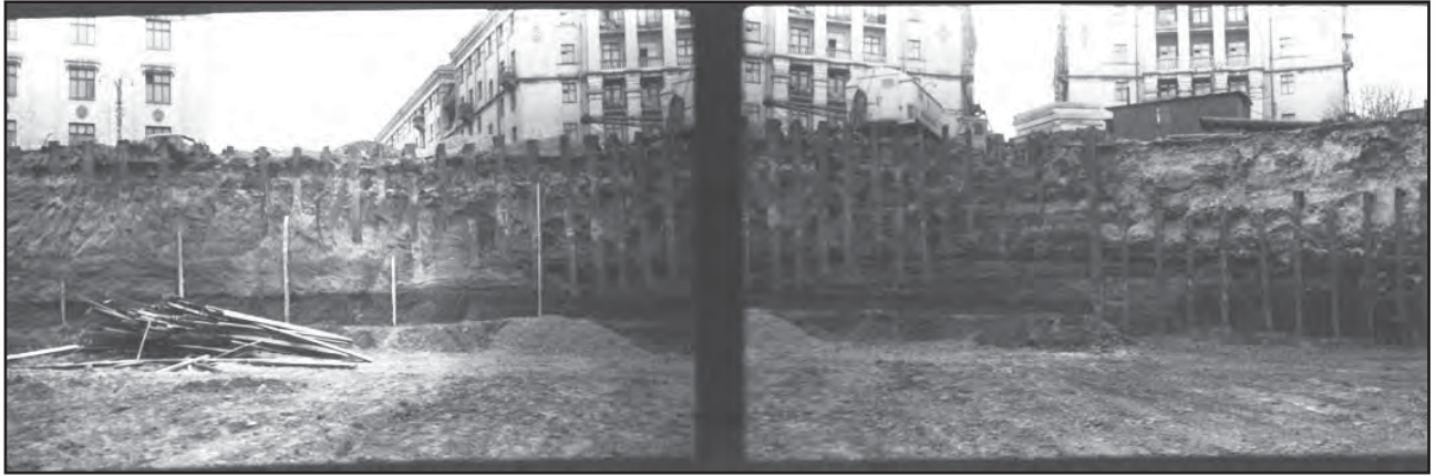
Гл. 2. Вигляд стратиграфічного розрізу будівельного котловану на площі Жовтневої революції (Майдан Незалежності) у 1981 р. На правому фото помітні залишки валу та рову.
